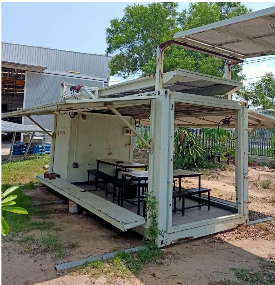
ภาพที่ 6.1.16 โครงการพัฒนาสร้างตู้พลังงานแสงอาทิตย์อเนกประสงค์ ที่มา: บริษัท โซล่าเพาเวอร์เทคโนโลยี จำกัด
